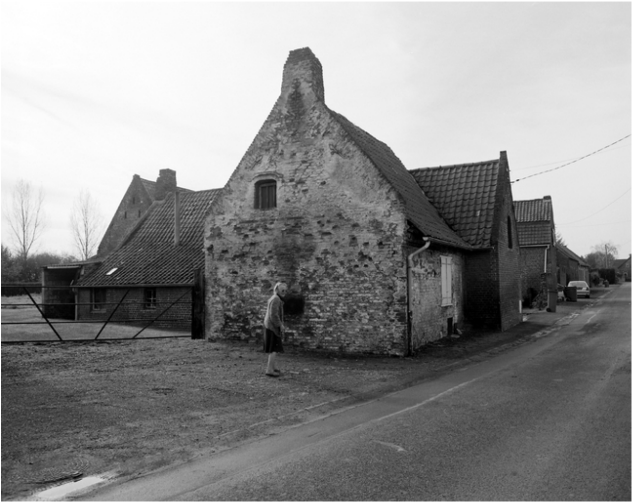
137, rue de la Caisse, pignon.
