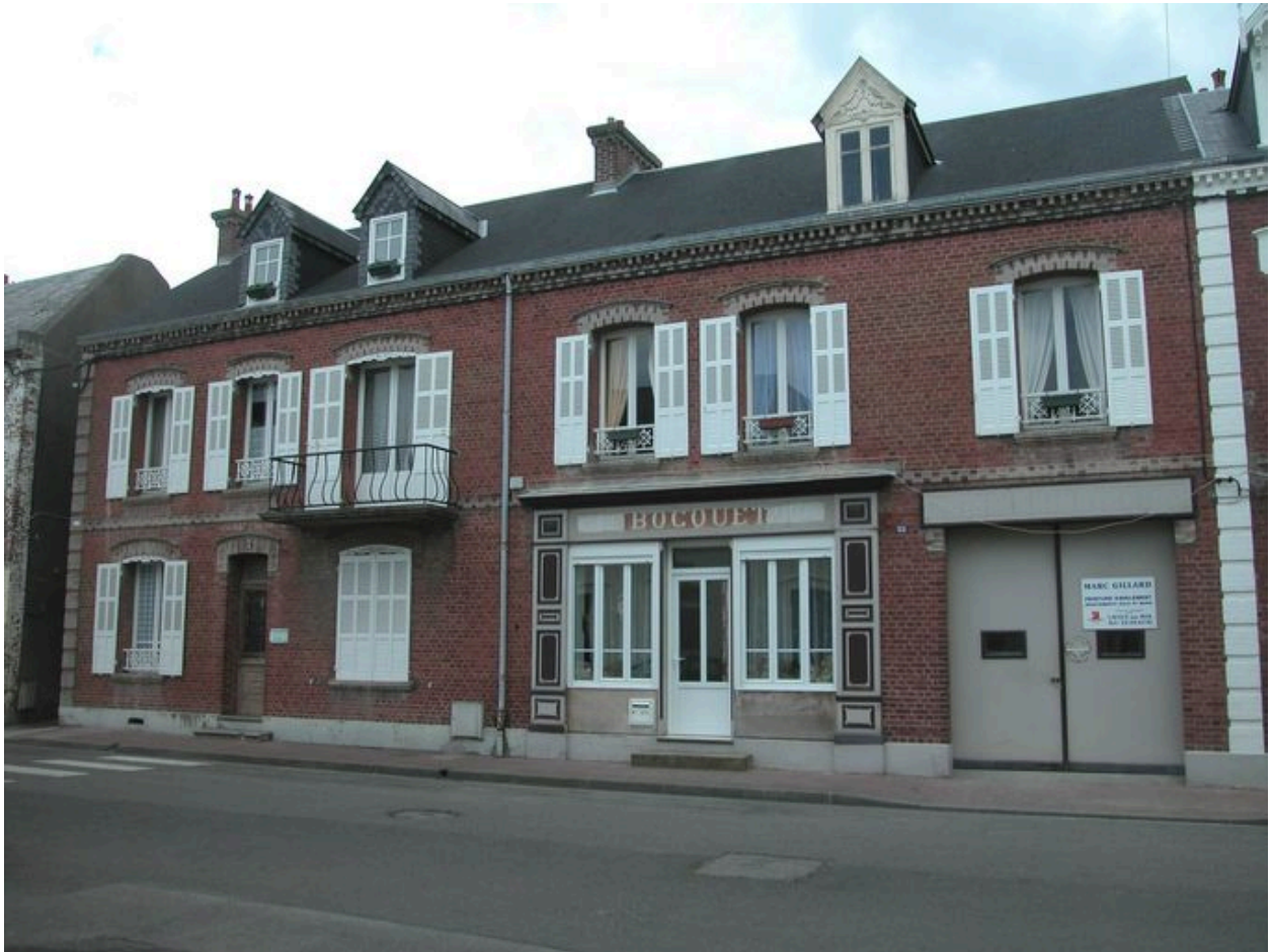
Vue d'ensemble des deux logements de gauche.
