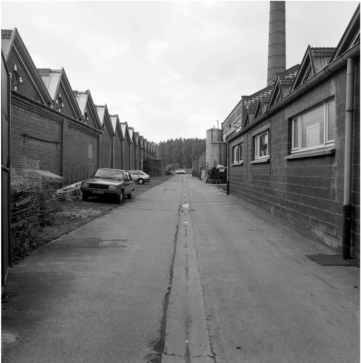
Atelier de fabrication, façade ouest. Vue prise vers le sud.
