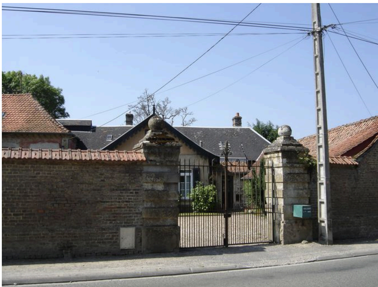
Vue de l'accès au n°55.
