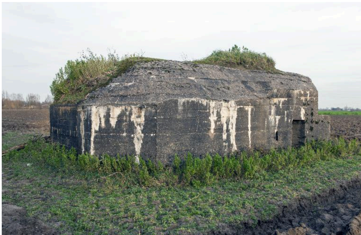
Vue de trois-quarts arrière, vers le nord-est
