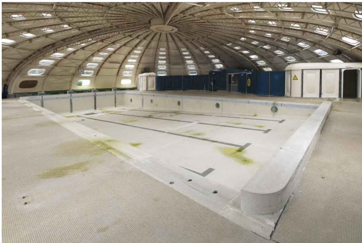
Vue intérieure du bassin.
