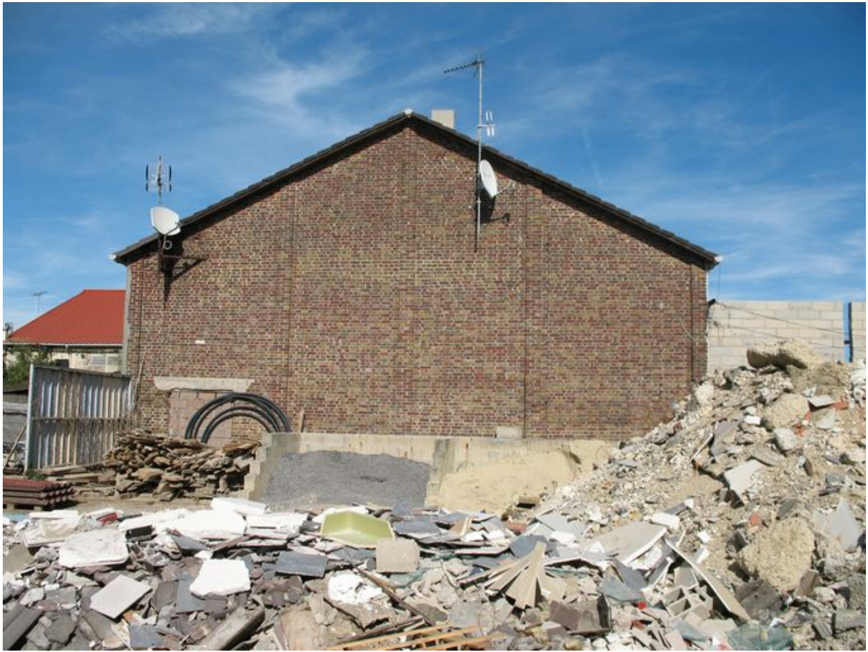
Mur pignon ouest de l'ancienne centrale.
