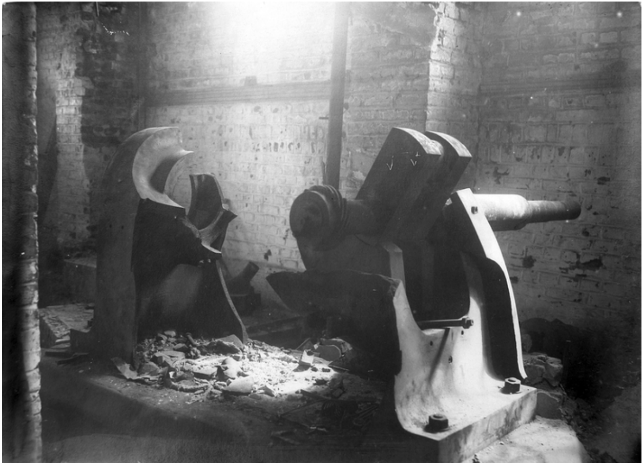
Vestiges de l'un des deux moteurs à gaz de l'usine, 1918-1919 (AD Aisne).
