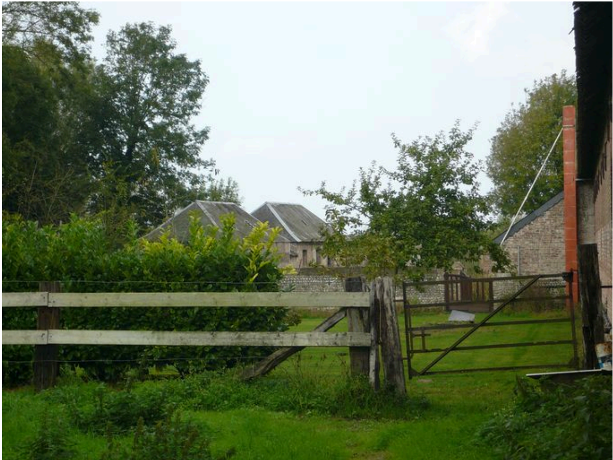
Vue des deux bâtiments indépendants au nord-ouest de la propriété.
