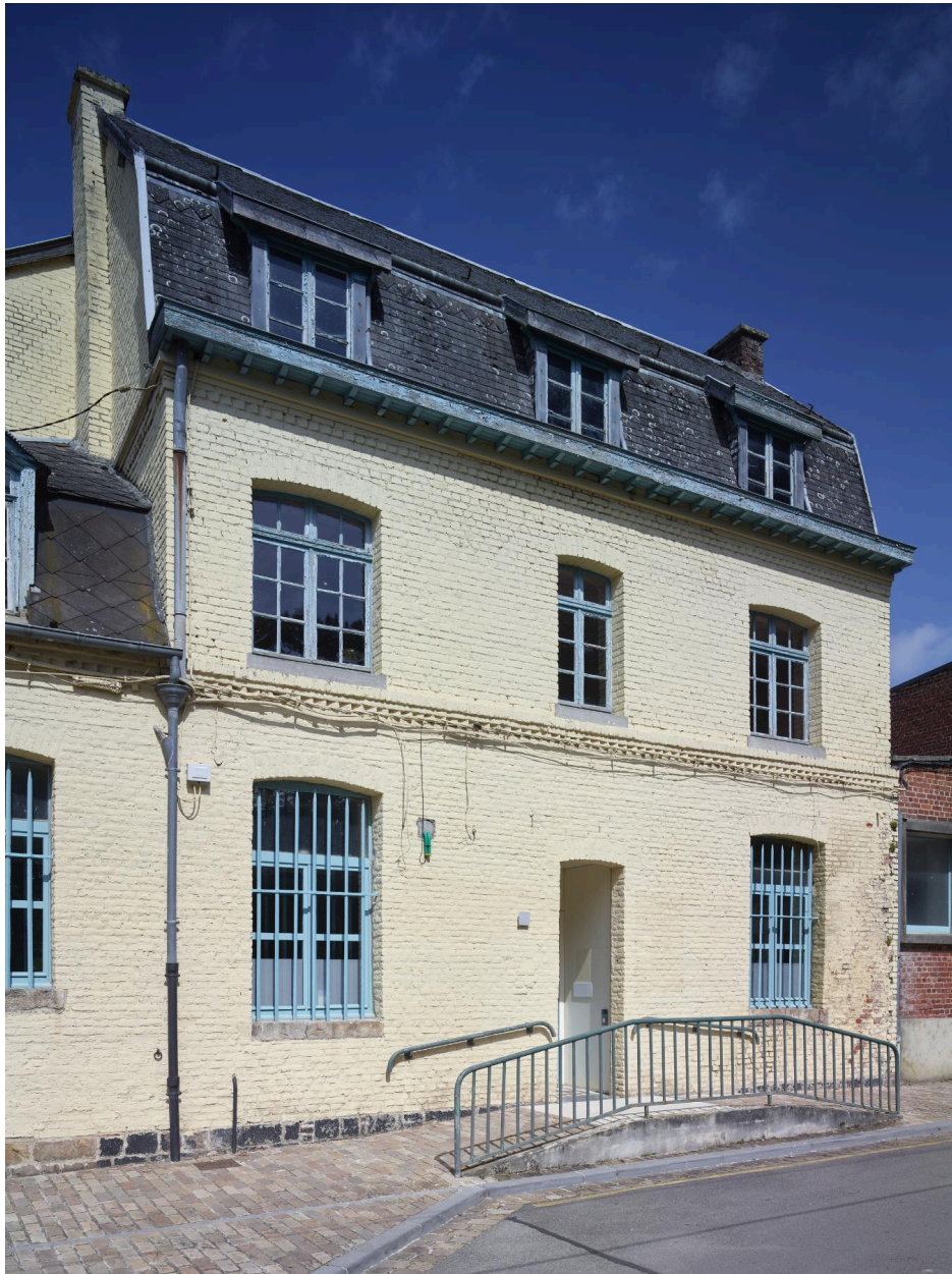
Détail du pavillon à l'extrémité est de la façade rue Chevray.
