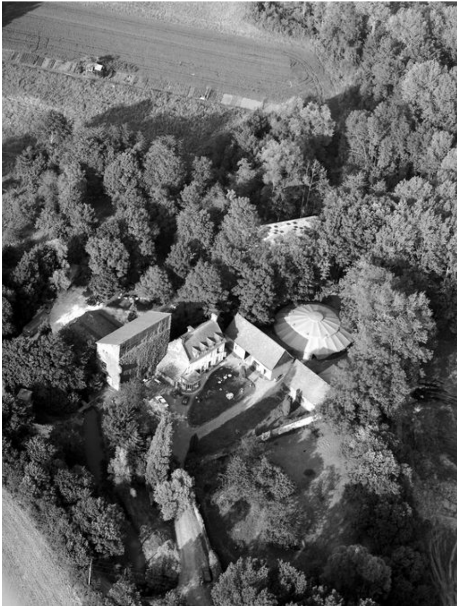
Vue aérienne du moulin de pierre en 1994.
