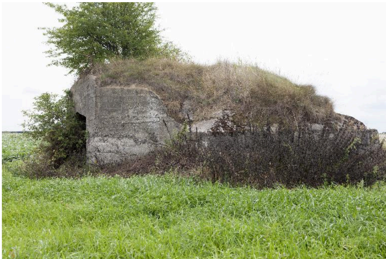
Vue latérale vers le sud
