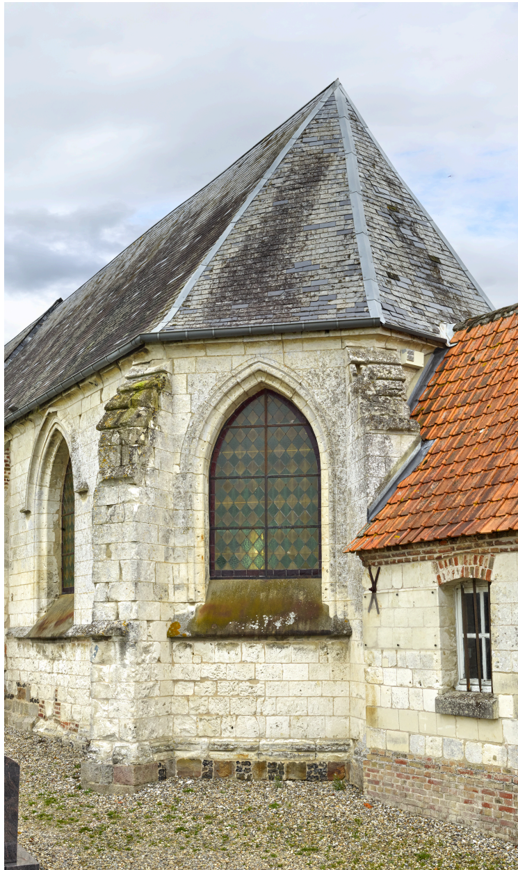
Détail d'une travée de l'élévation sud du chœur.
