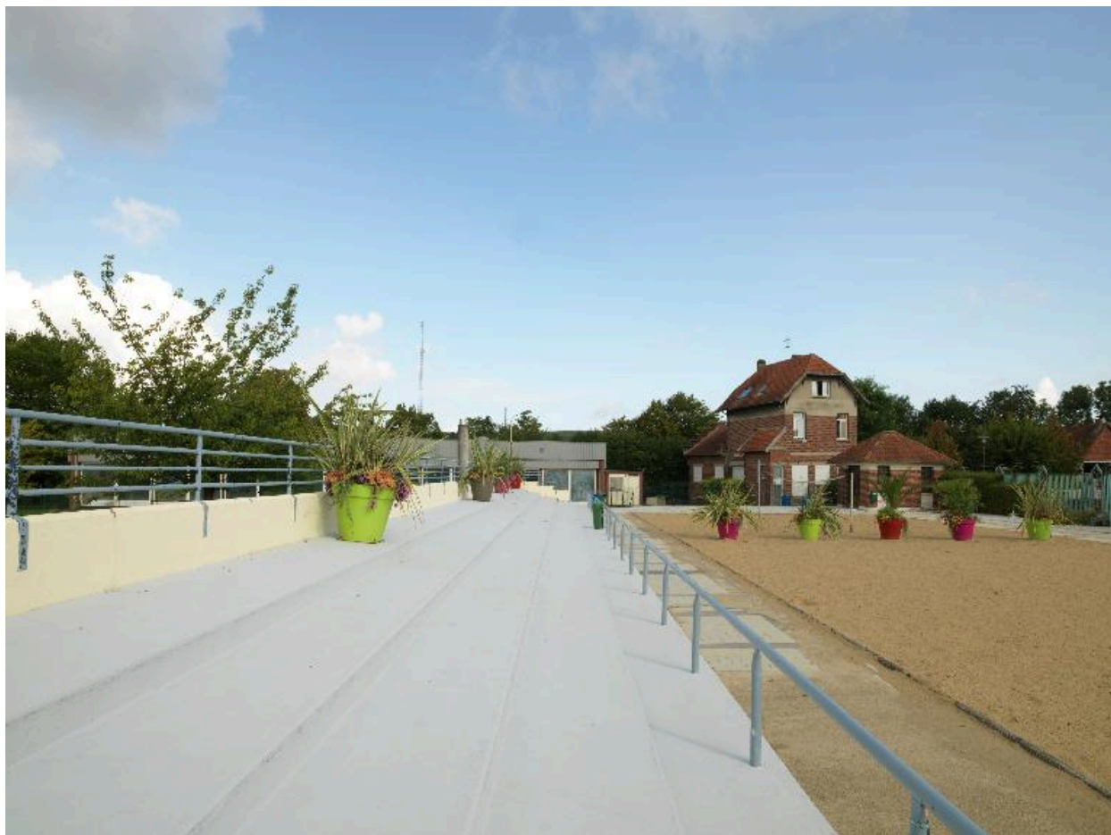
Gradins de l'ancienne piscine découverte.
