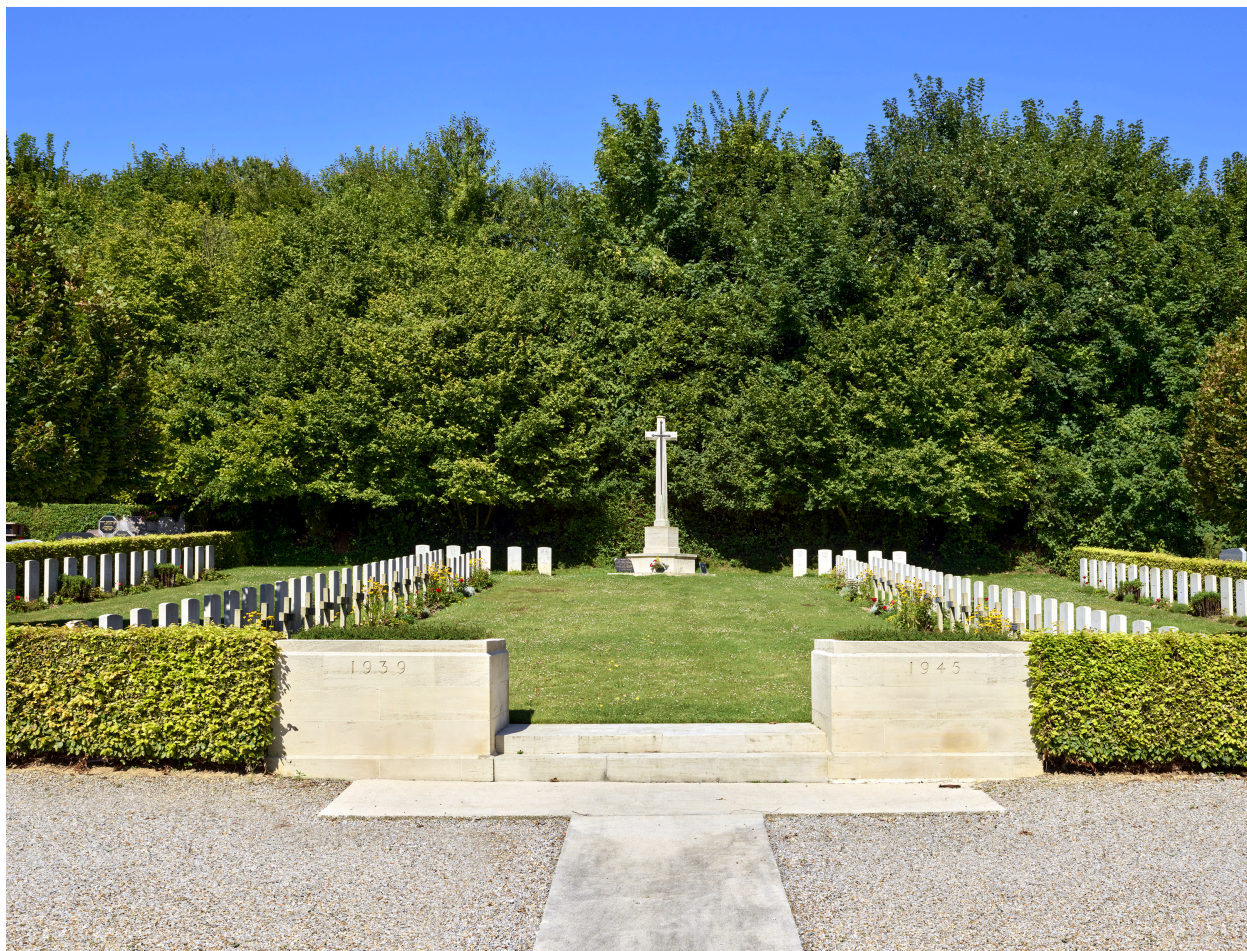
Vue de l'entrée du cimetière militaire, depuis le sud-est.
