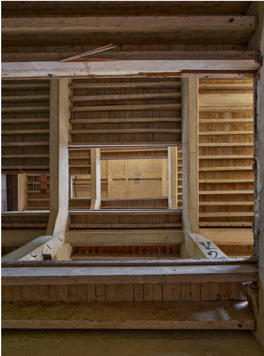
Passage des tremis à planchisters à chaque niveau de la minoterie.
