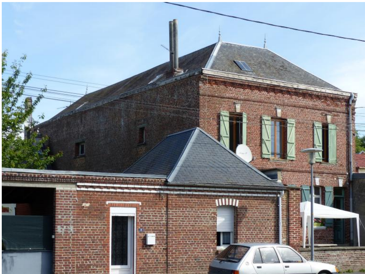
Vue de détail sur les anciens ateliers.
