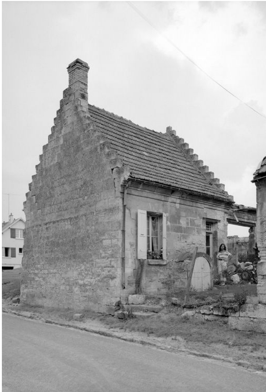
Ancienne grange transformée en logement.
