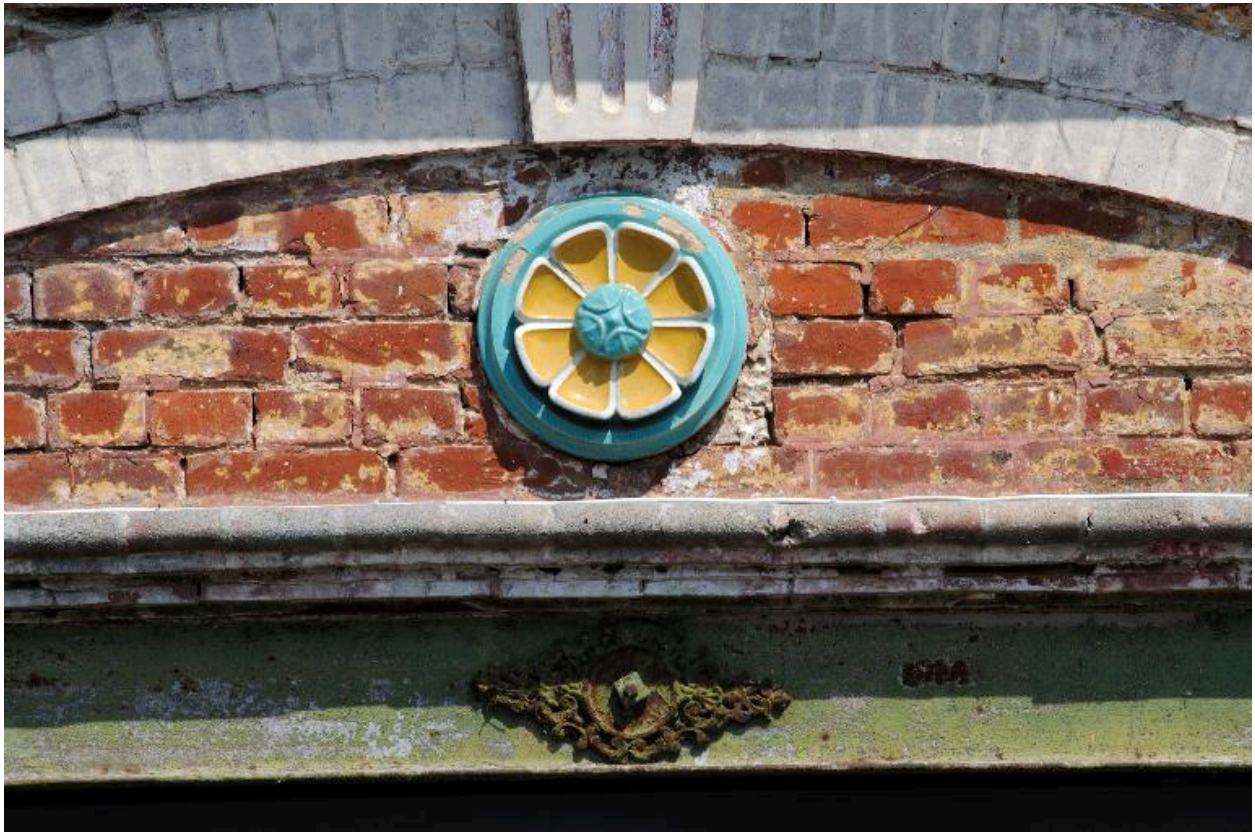
Détail du motif floral en céramique vernissée surmontant l'entrée charretière.
