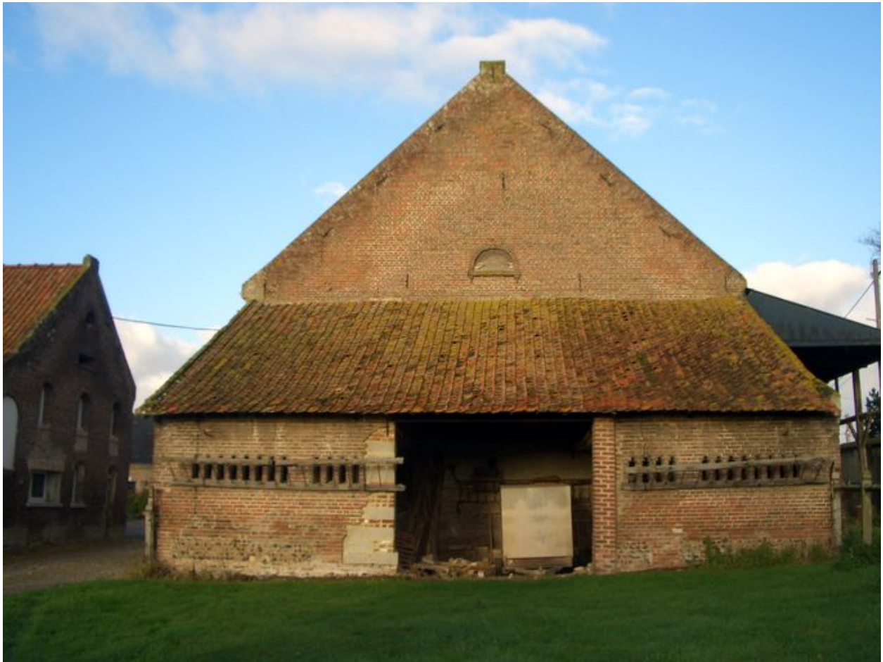
Vue du pignon est des bouveries.
