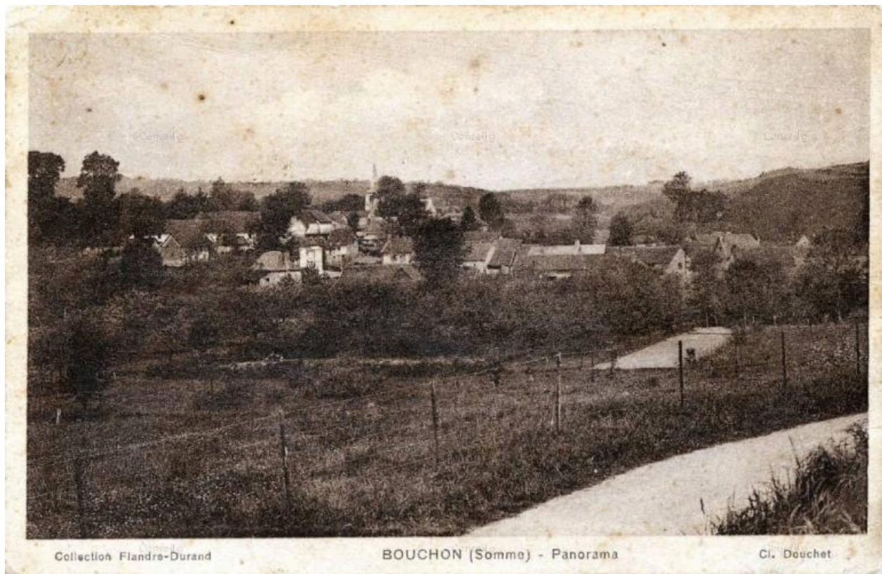
Vue générale depuis l'est, années 1920-1930 (AD Somme ; non coté).
