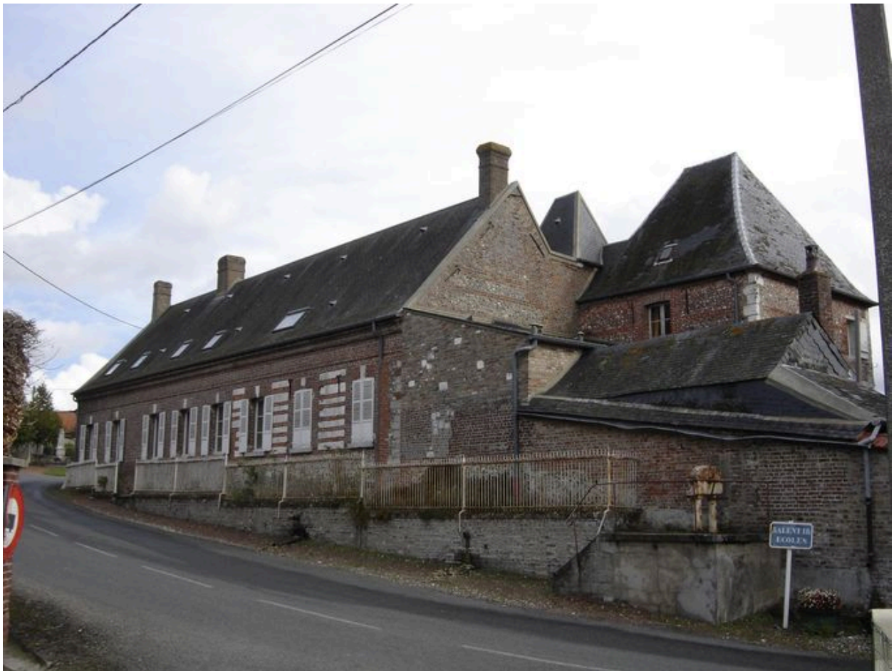
Vue du logis sur rue.
