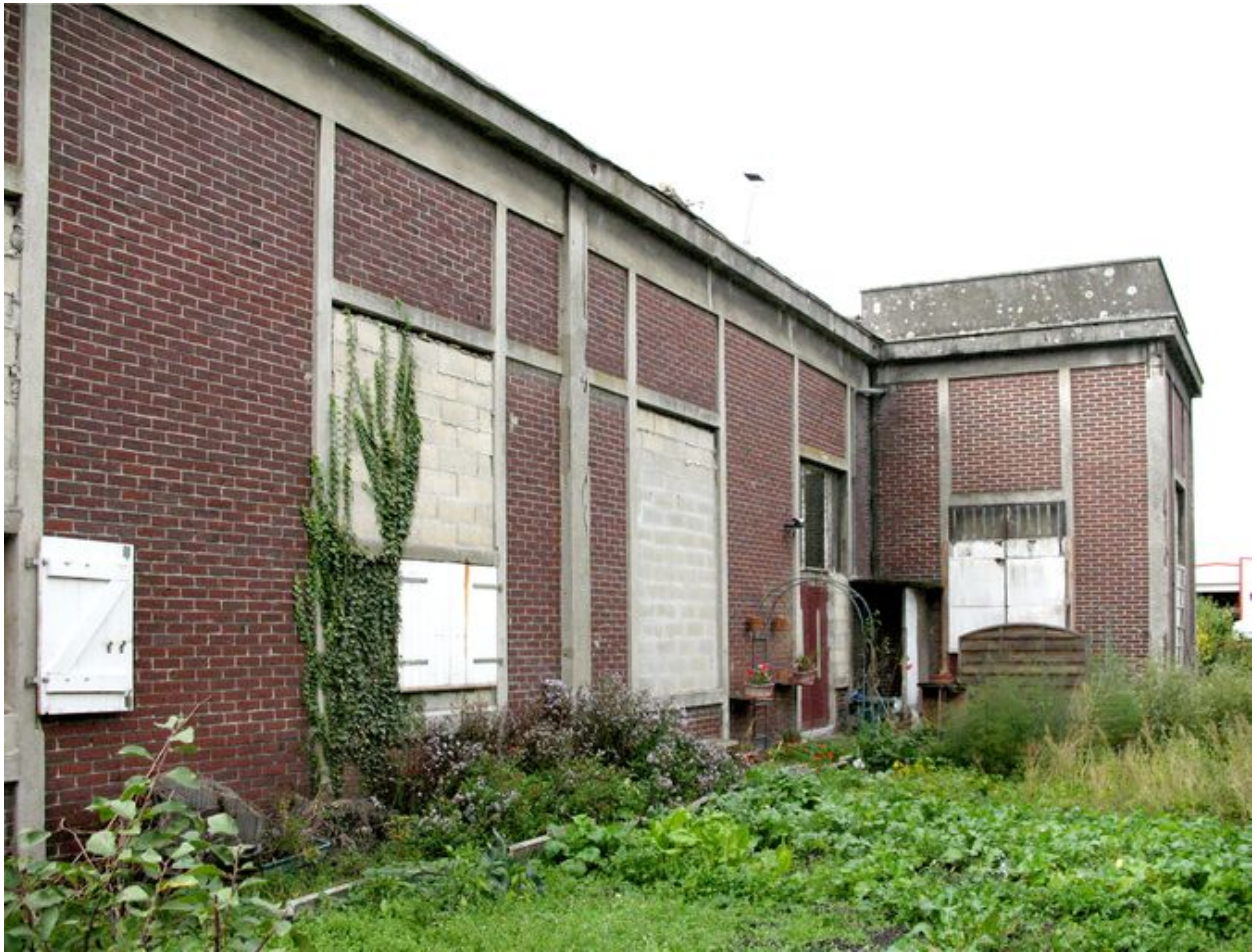
Façade est de la station de pompage et annexe surmontée du réservoir d'eau.
