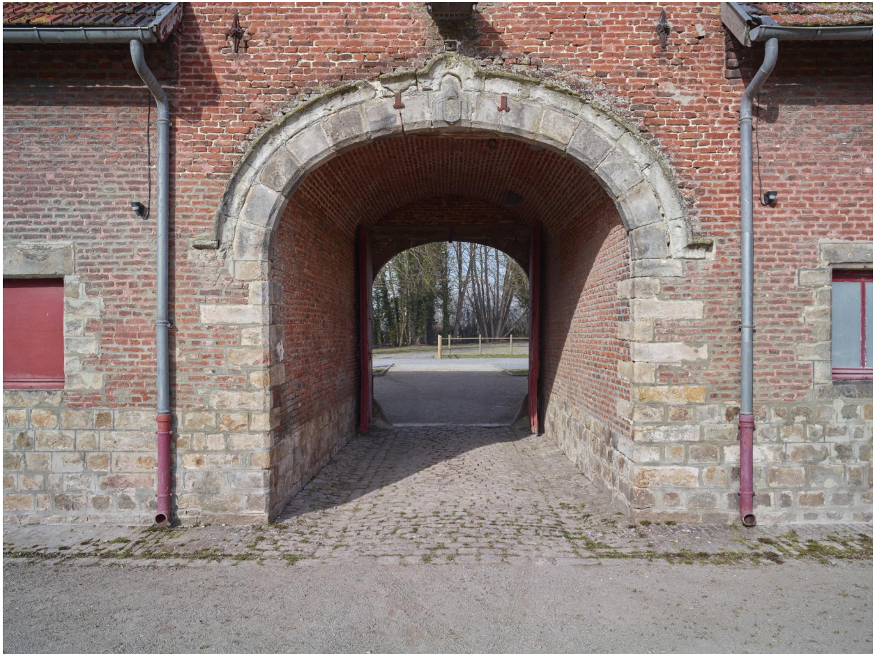
Passage charretier sous la tour porche. Vue prise depuis la cour intérieure. Blason de Jean Sarrazin en clé de voûte.
