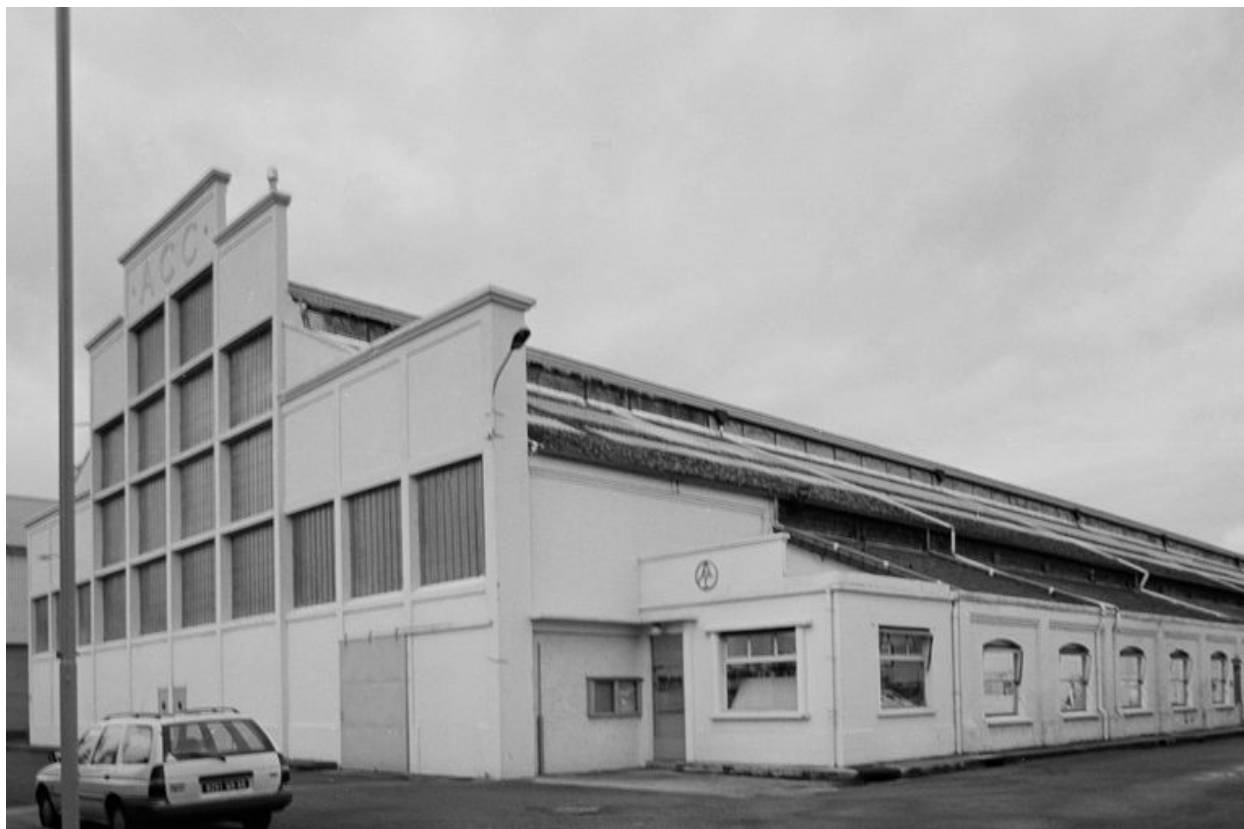
Atelier de fabrication : flanc sud-ouest.
