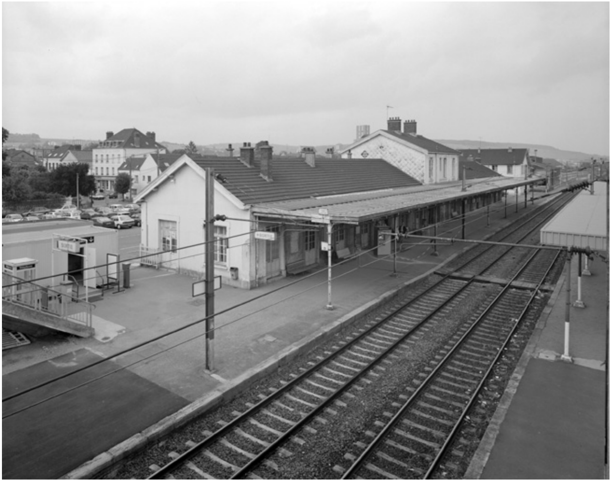
Vue du bâtiment central et des voies à partir de la passerelle.
