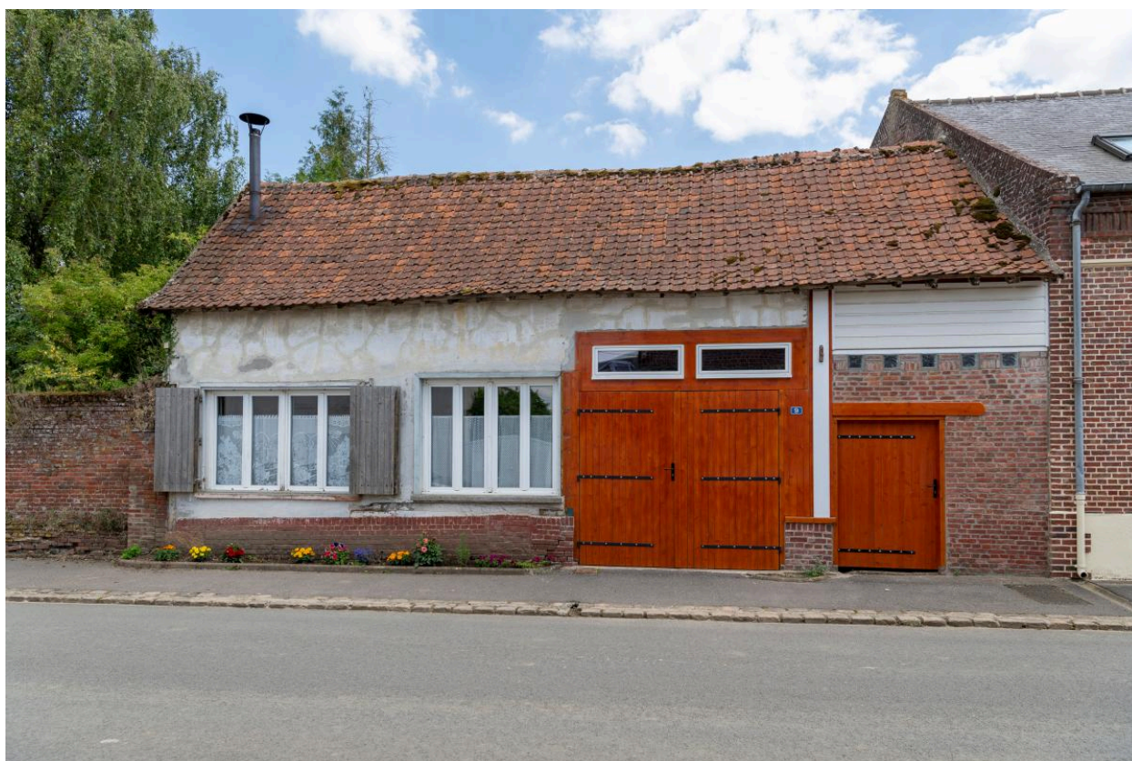
Ancien commerce (?), n°9 rue de la Gare, vue depuis le nord-ouest.
