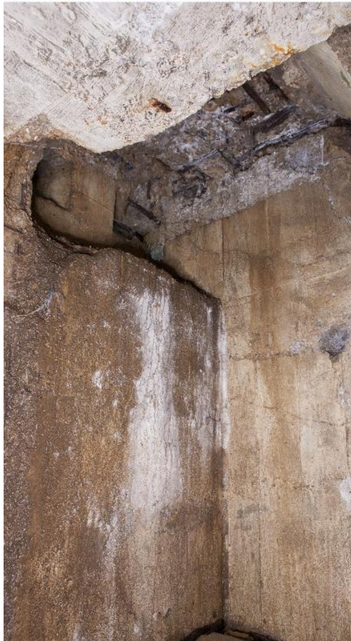
Casemate A : Vue intérieure, créneaux de fusillade ou d'observation
