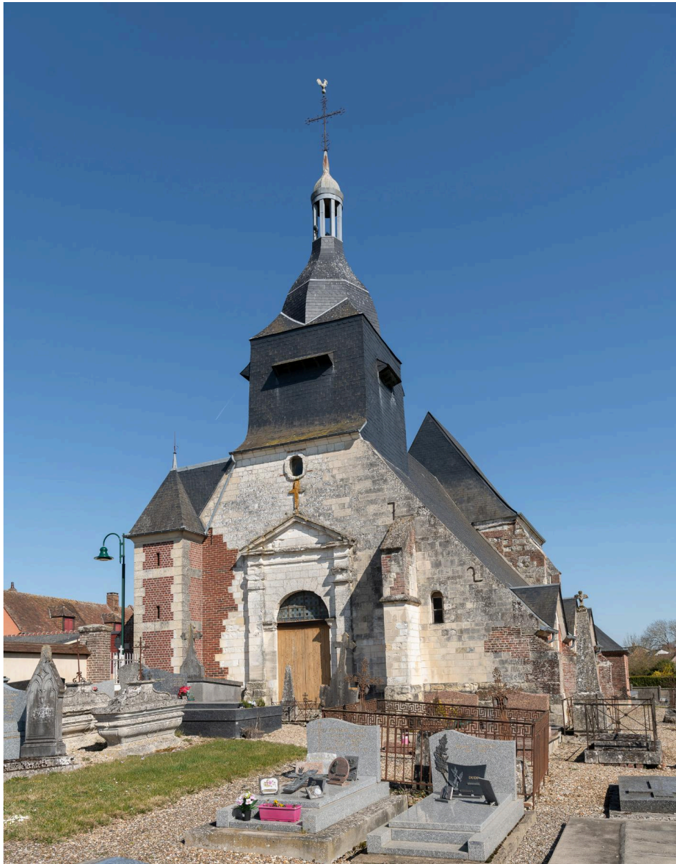
Vue générale de la façade occidentale.
