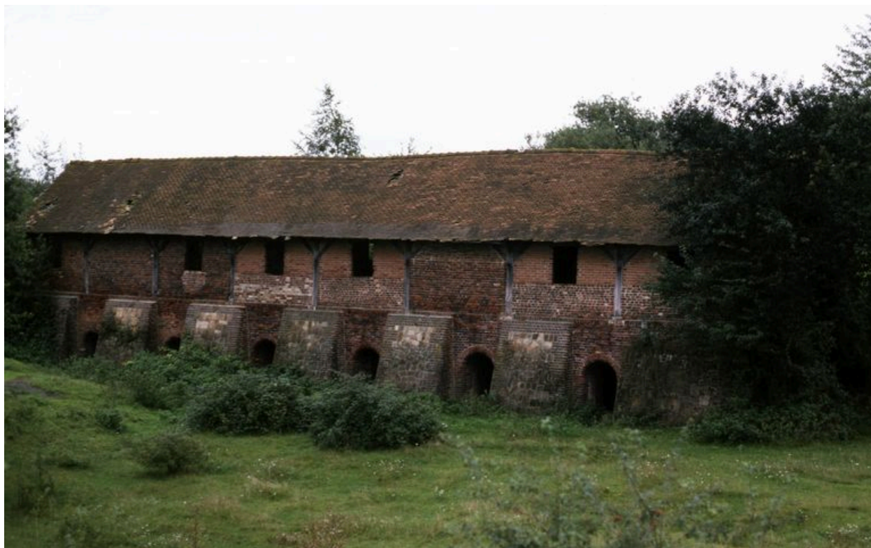
Four industriel de type Hoffmann, côté nord.
