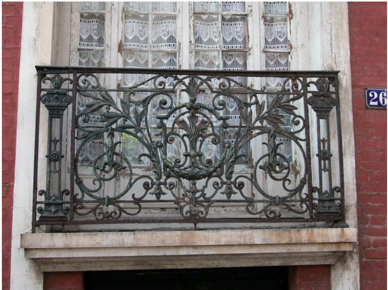
Détail d'un garde-corps en fonte de l'habitation dite Henriette.
