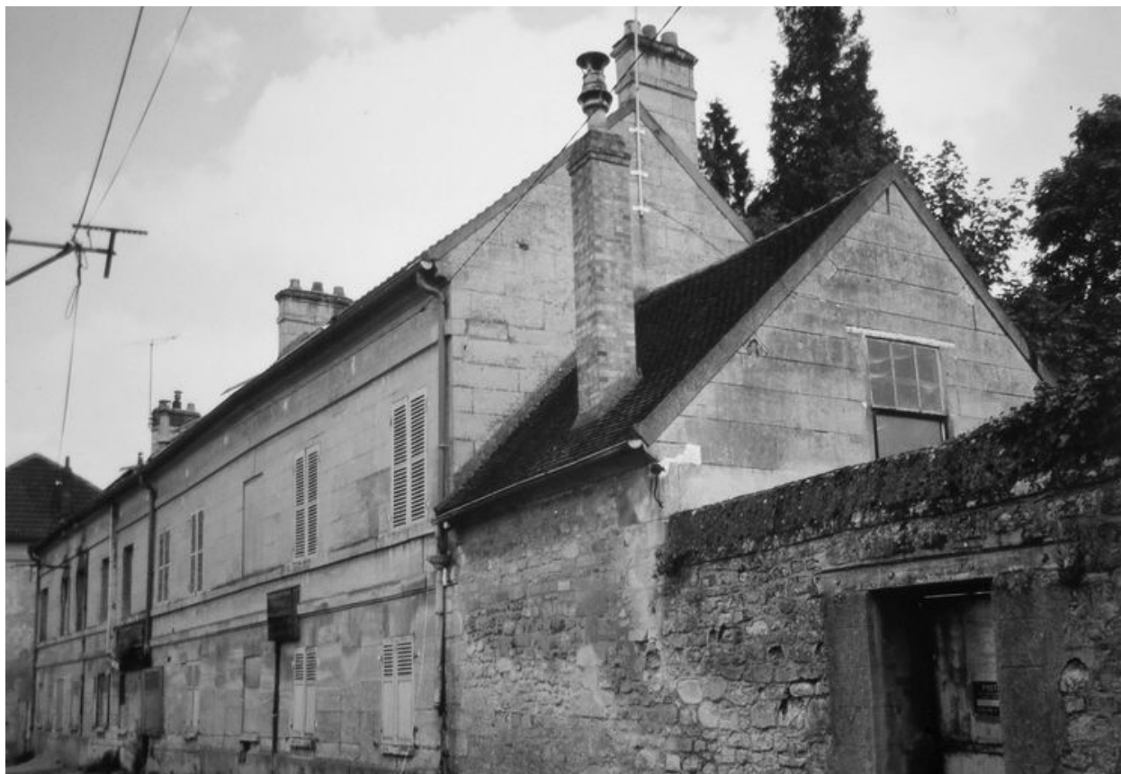
Façade sur rue du logement patronal et des bureaux.
