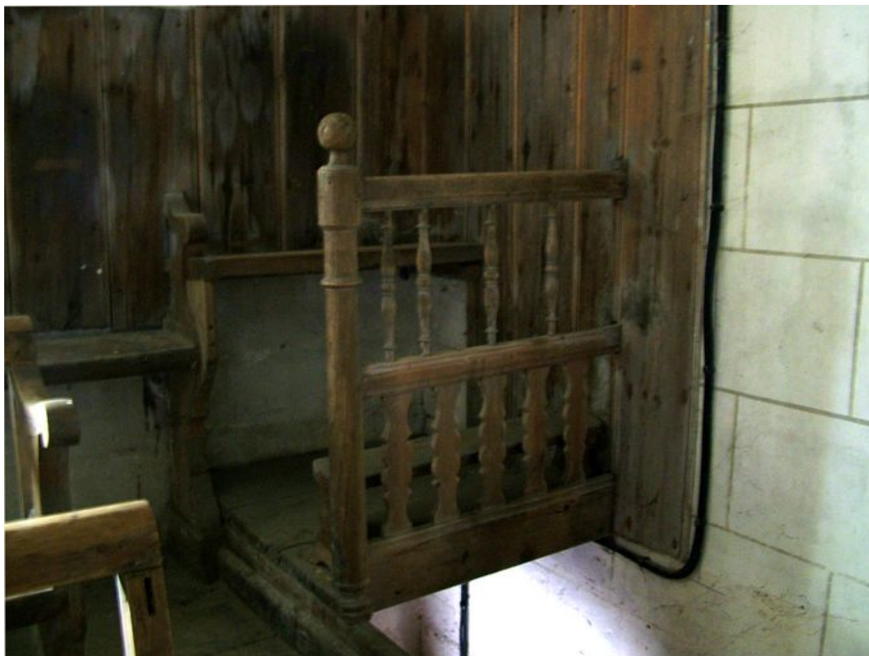
Petite tribune surplombant l'escalier.
