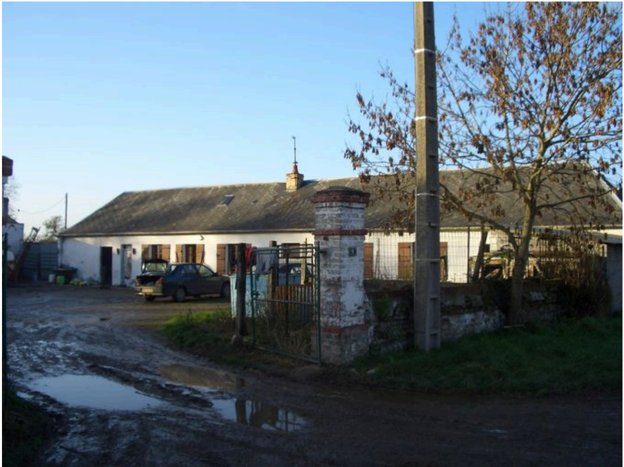
Vue du logis depuis la rue.
