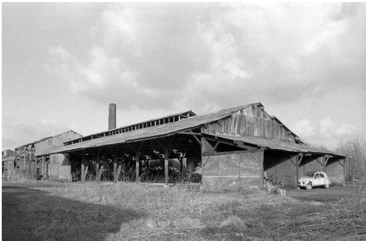
Hangar industriel, flanc sud.
