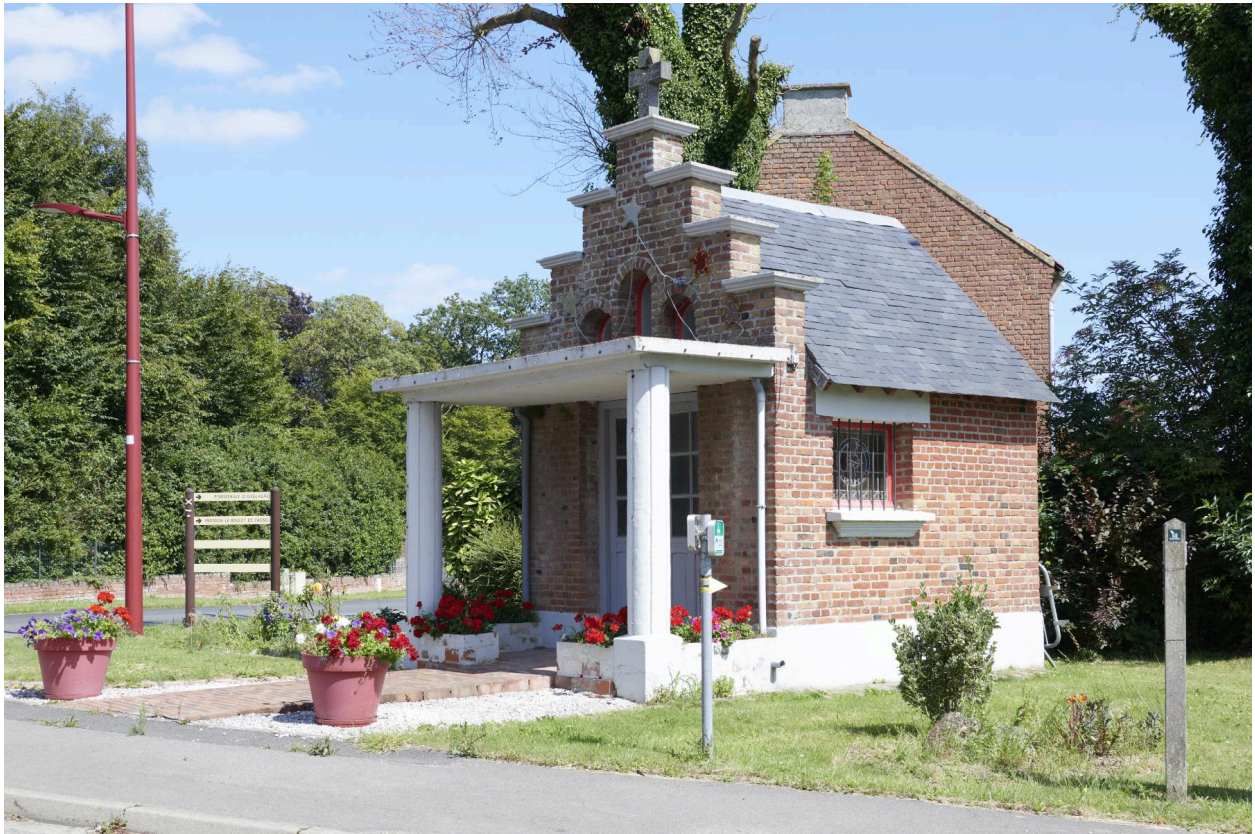
Façade et côté sud de la chapelle.
