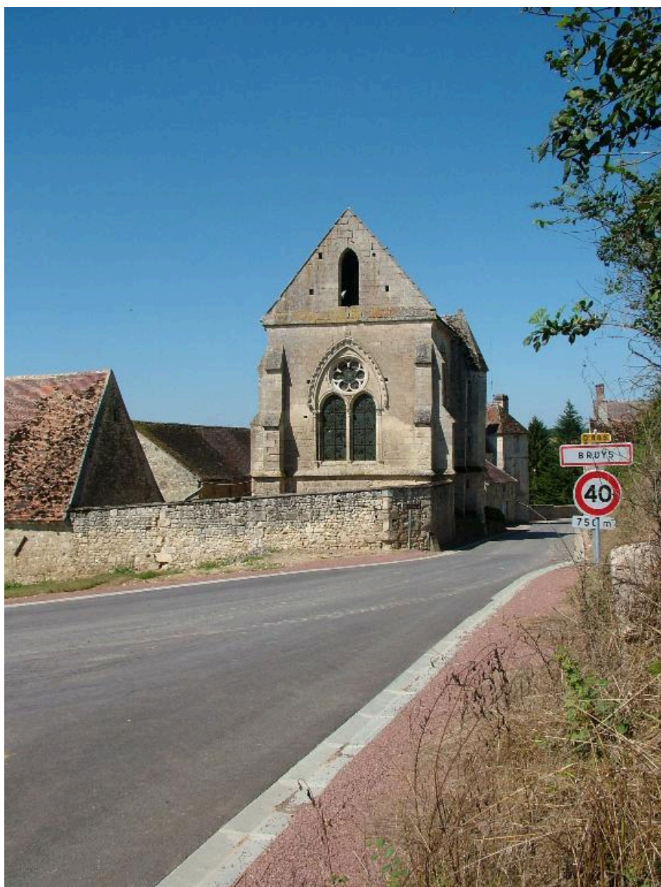
Vue de situation, depuis l'entrée du village.
