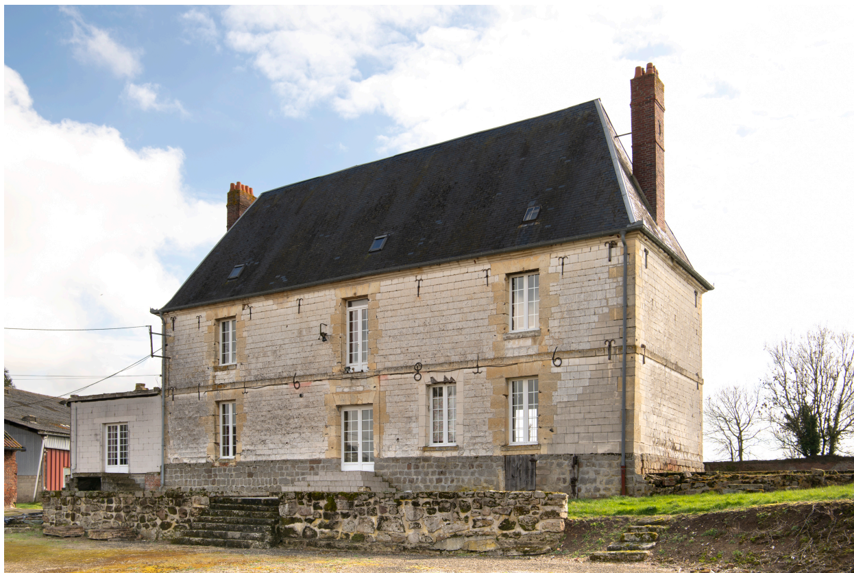
Vue de trois quarts du logis depuis le nord.
