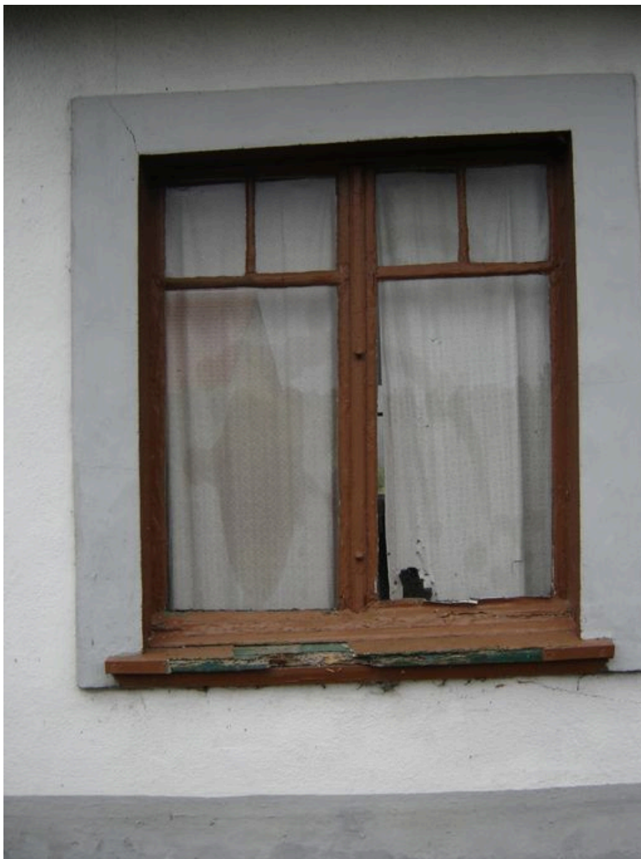
Vue d'une fenêtre.
