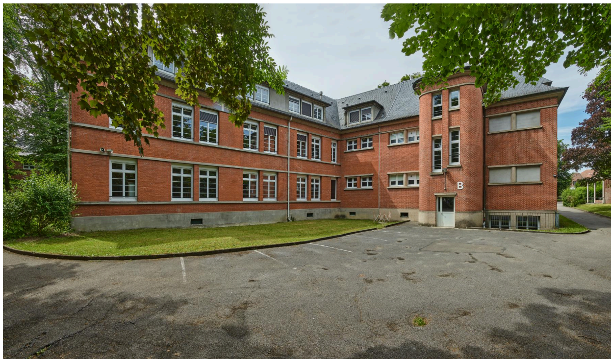
Bâtiment B du lycée Pierre d'Ailly, internat, vue du nord-ouest.
