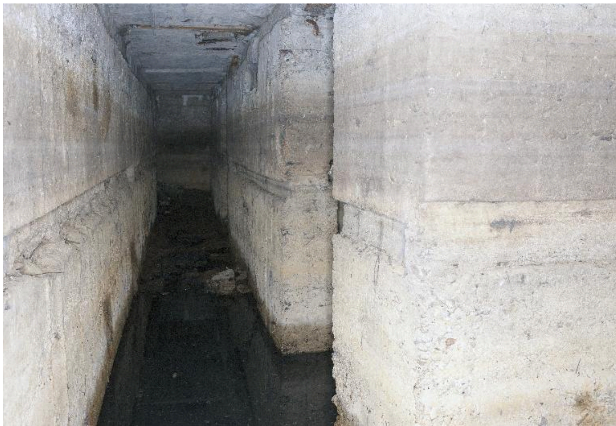
Vue en enfilade du couloir C1, vers l'ouest
