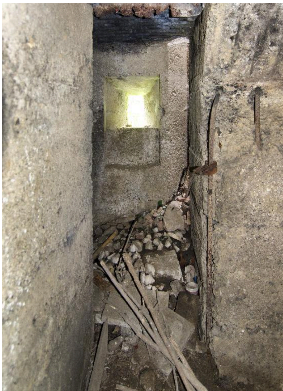
Créneau de fusillade nord
