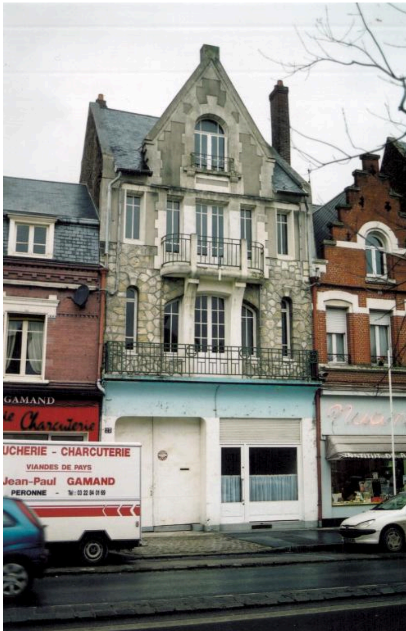
Maison, 23 rue Saint-Sauveur (B 339), reconstruite vers 1925.
