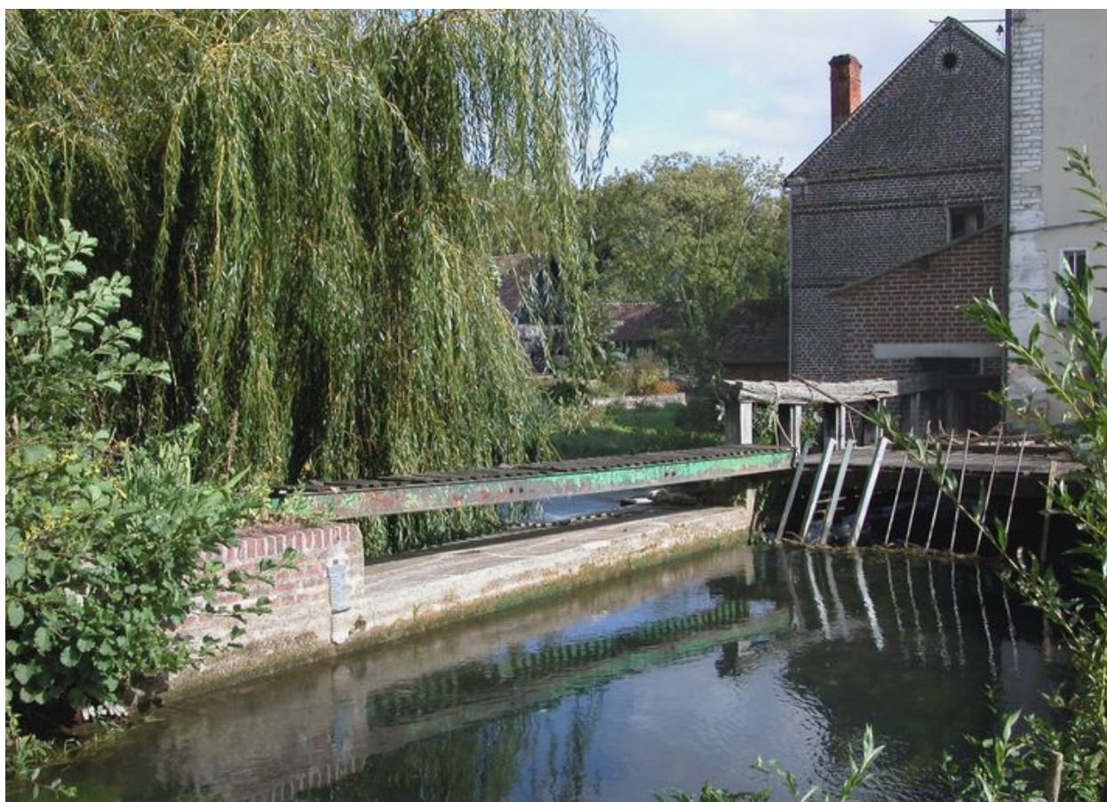
Le déversoir et le vannage de décharge.
