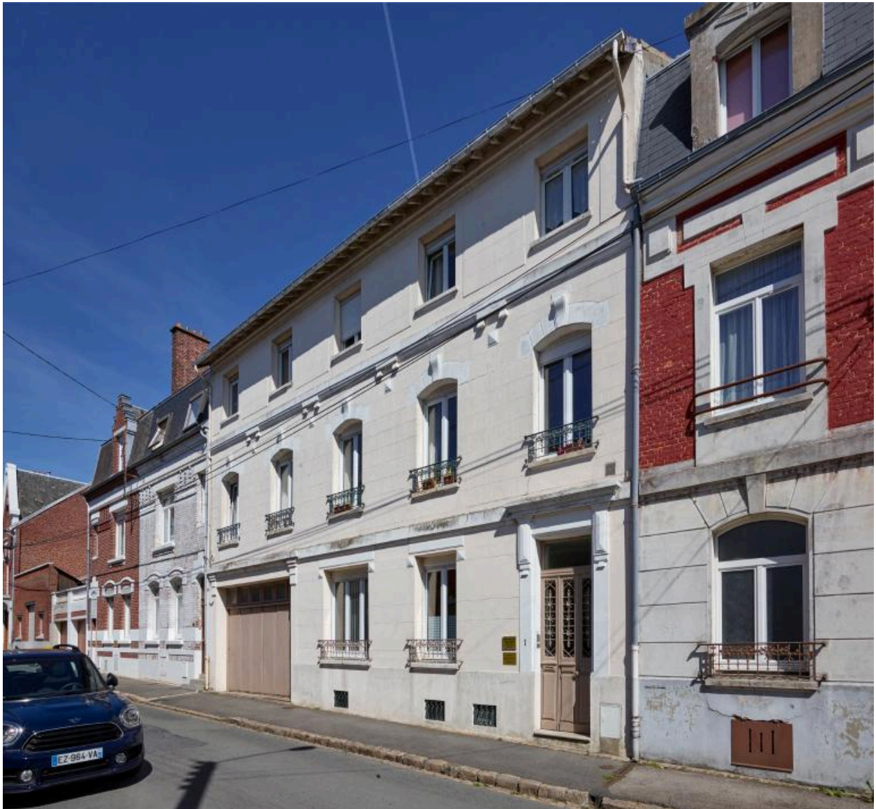
Vue générale de la façade rue Lecointe.
