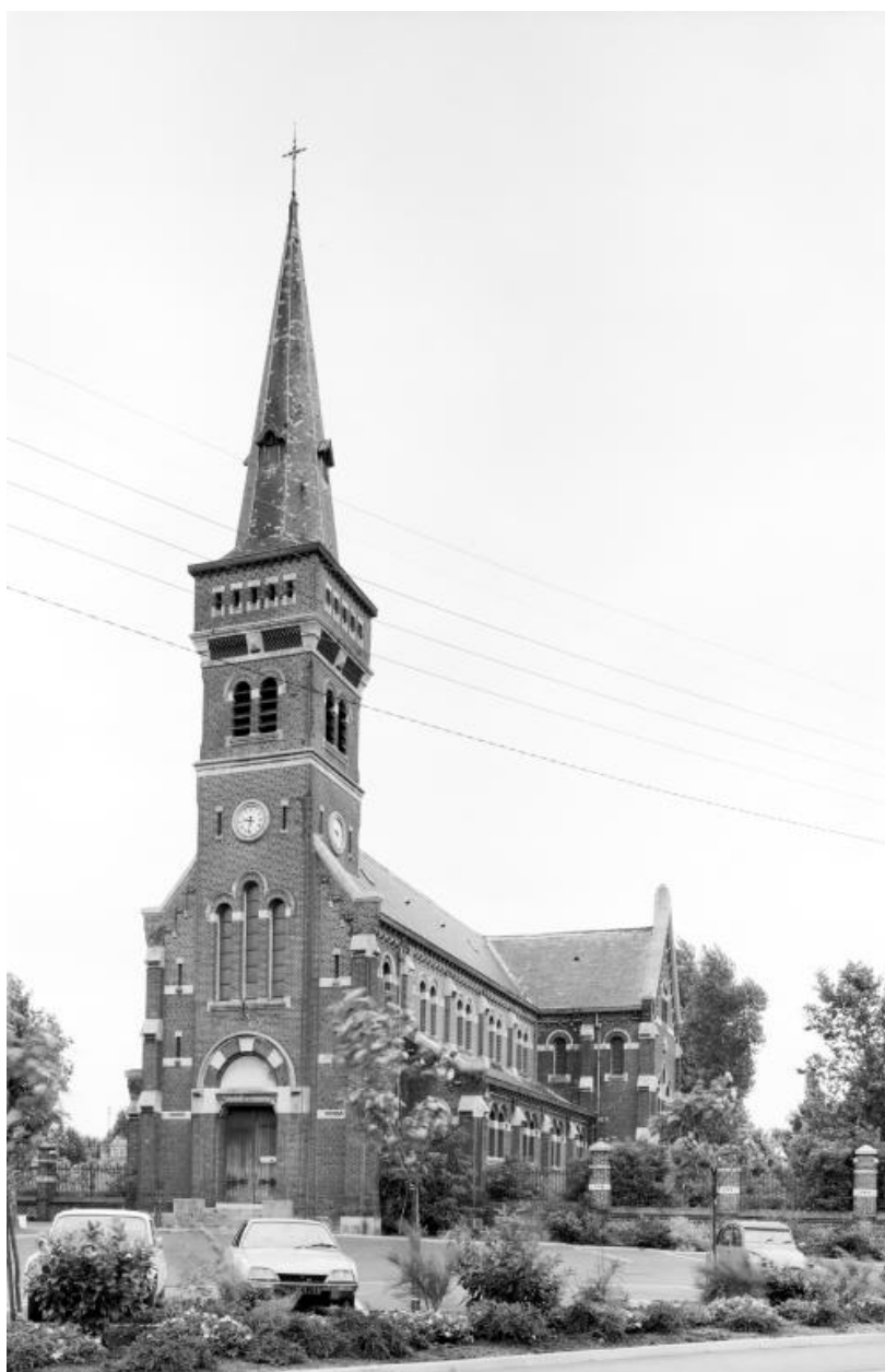
Vue de trois-quarts, vers le nord-est.
