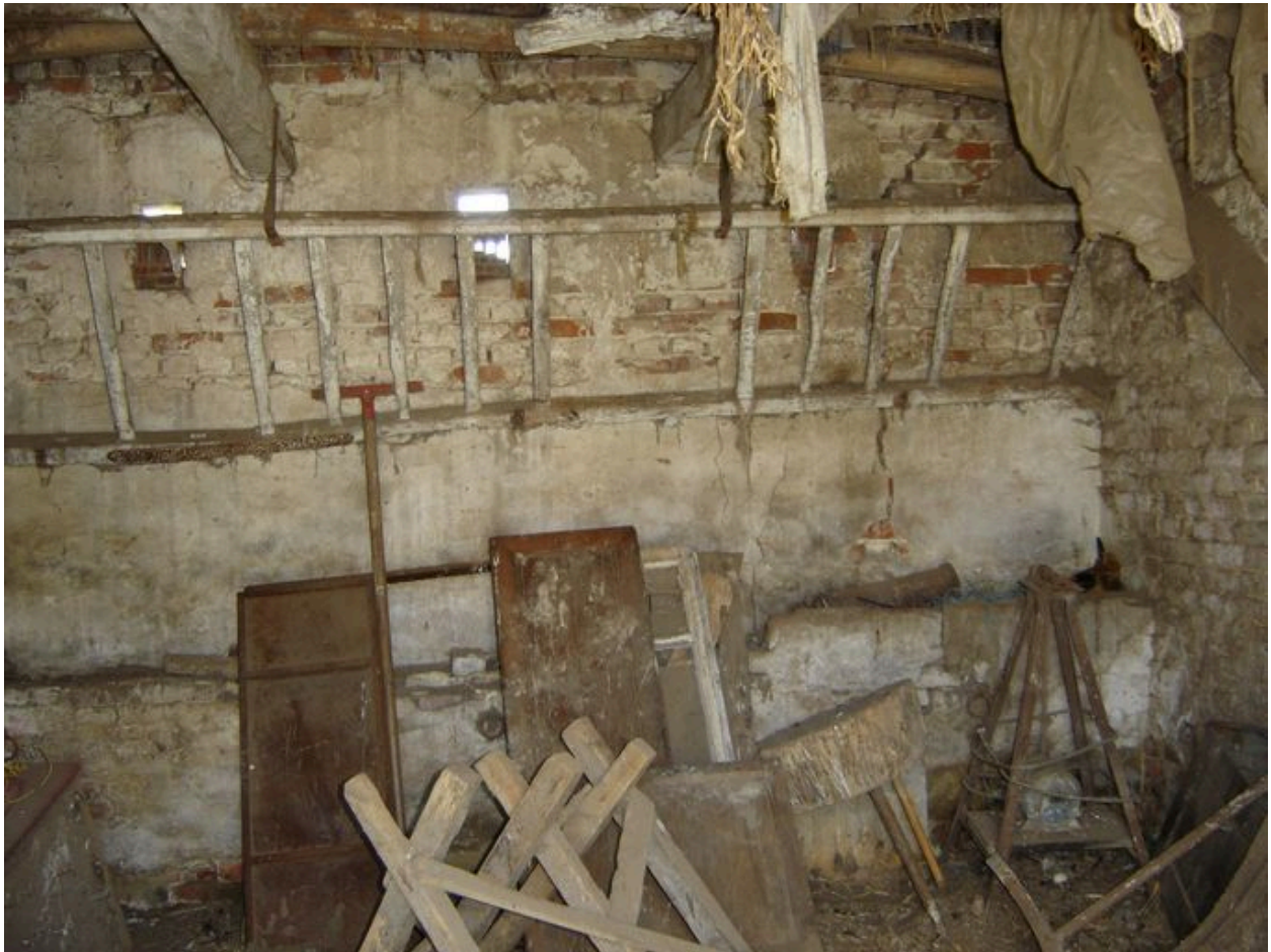
Vue intérieure de l'écurie.
