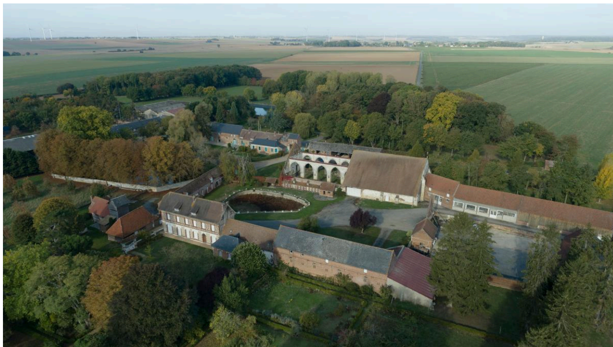
Vue aérienne des fermes depuis le sud-est.
