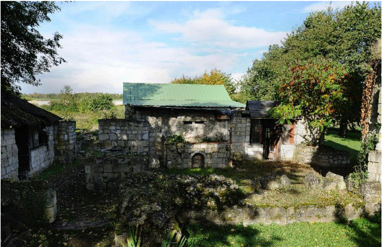
Anciens bâtiments des cuisines au sud du cloître, à proximité de la porterie.
