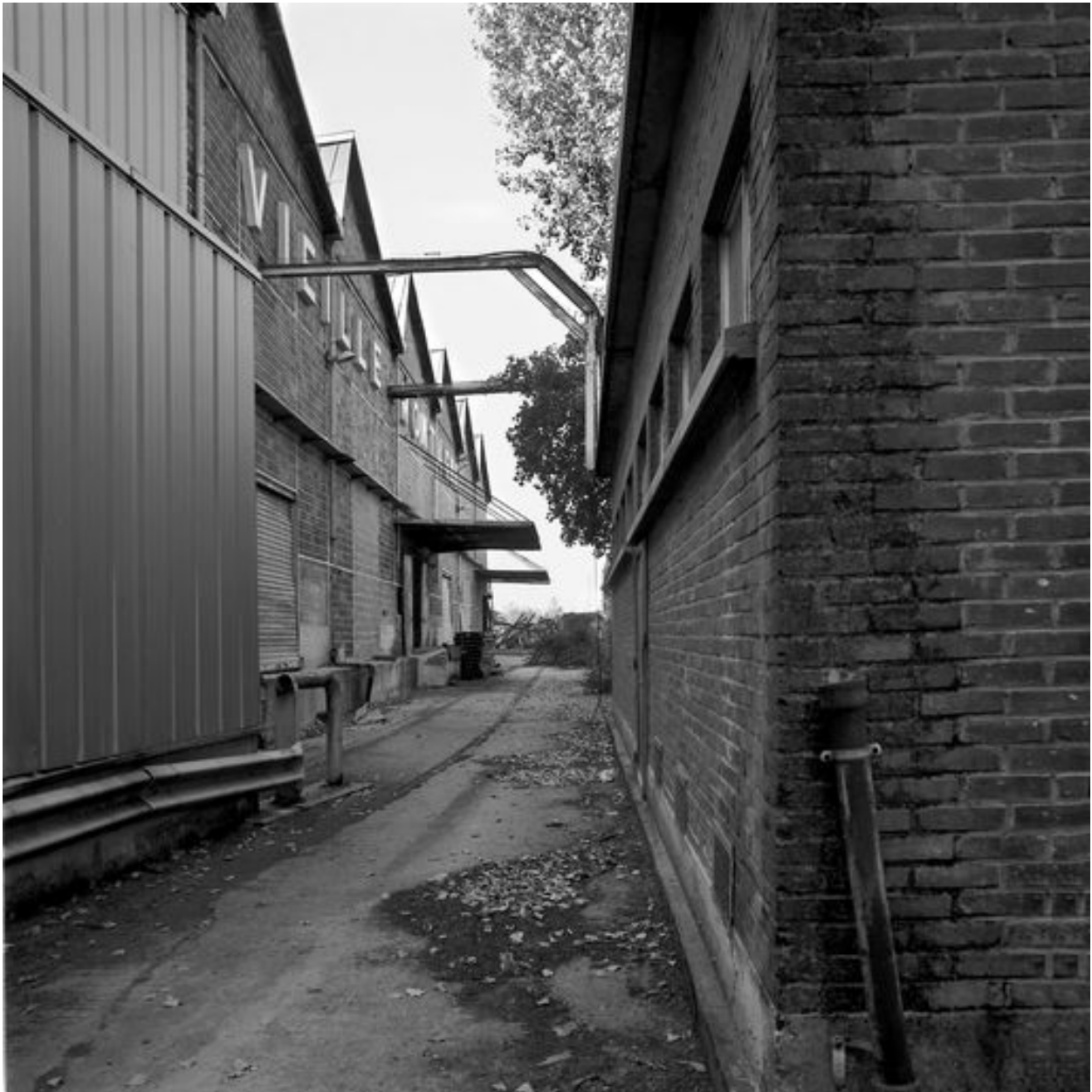
Quais de chargement et de déchargement.
